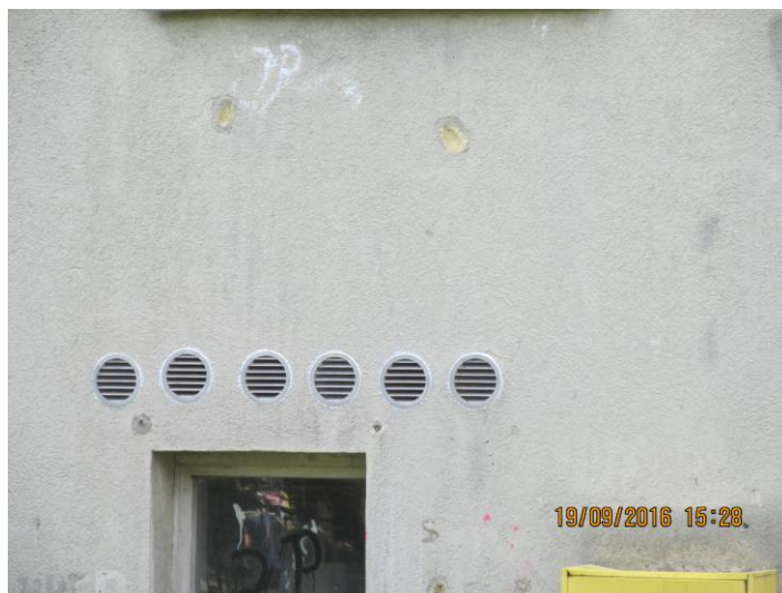
Fot. 6. Zakratowane otwory wentylacyjne.
